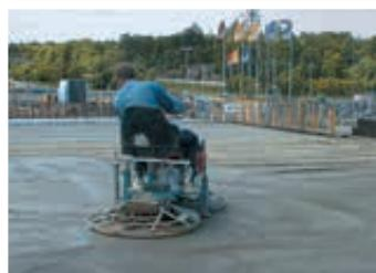
Penetron Plus được rắc bằng sàng và xoa bằng máy helicopter
